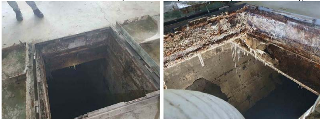
14,15 pav. Metalinių sijų korozija ties anga
