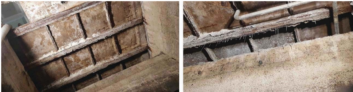
19,20 pav. Korozijos pažeista G/B perdanga
