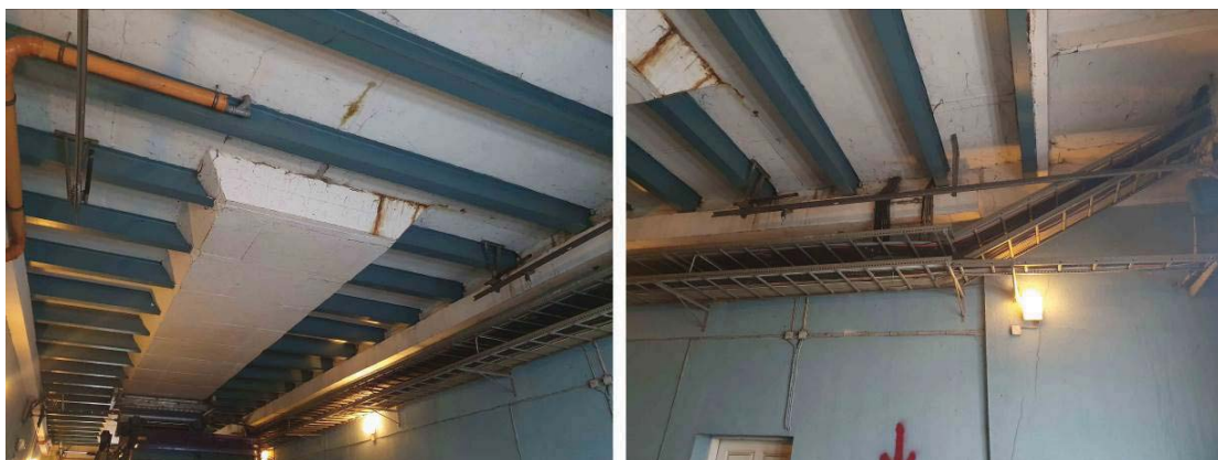
5,6 pav. Bunkerio dugno plokštės pažaidos
