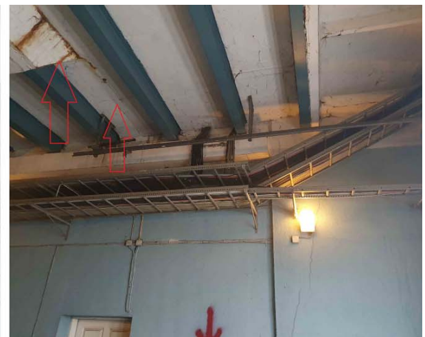
8,9 pav. bunkerio dugno plokštės pažaidos
