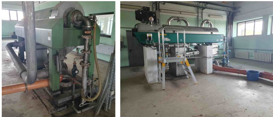
12,13 pav. Technologinė įranga išdėstyta ant bunkerio perdangos
