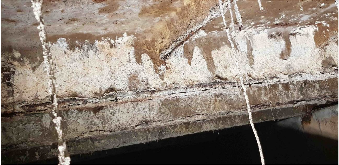
21 pav. Korozijos pažeista G/B perdanga
