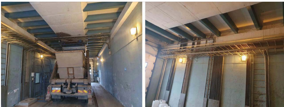
3,4 pav. bunkerio dugno plokštės esamos konstrukcijos
