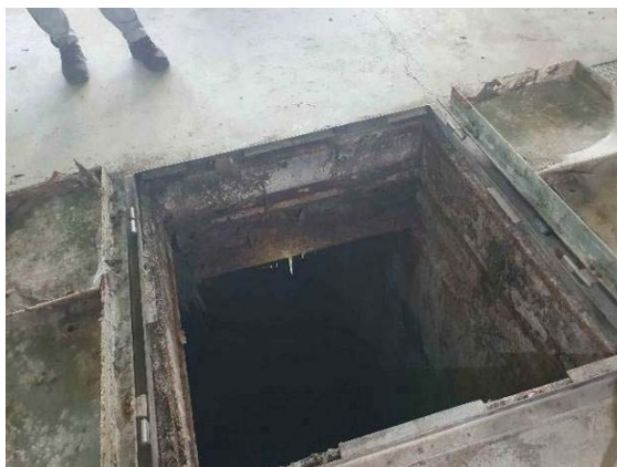
11,12 pav. Metalinių sijų korozija ties anga
