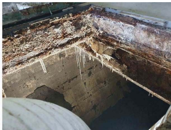
11,12 pav. Metalinių sijų korozija ties anga
