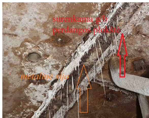
19,20 pav. Dvitėjinės metalinės sijos ir perdangos detalė
