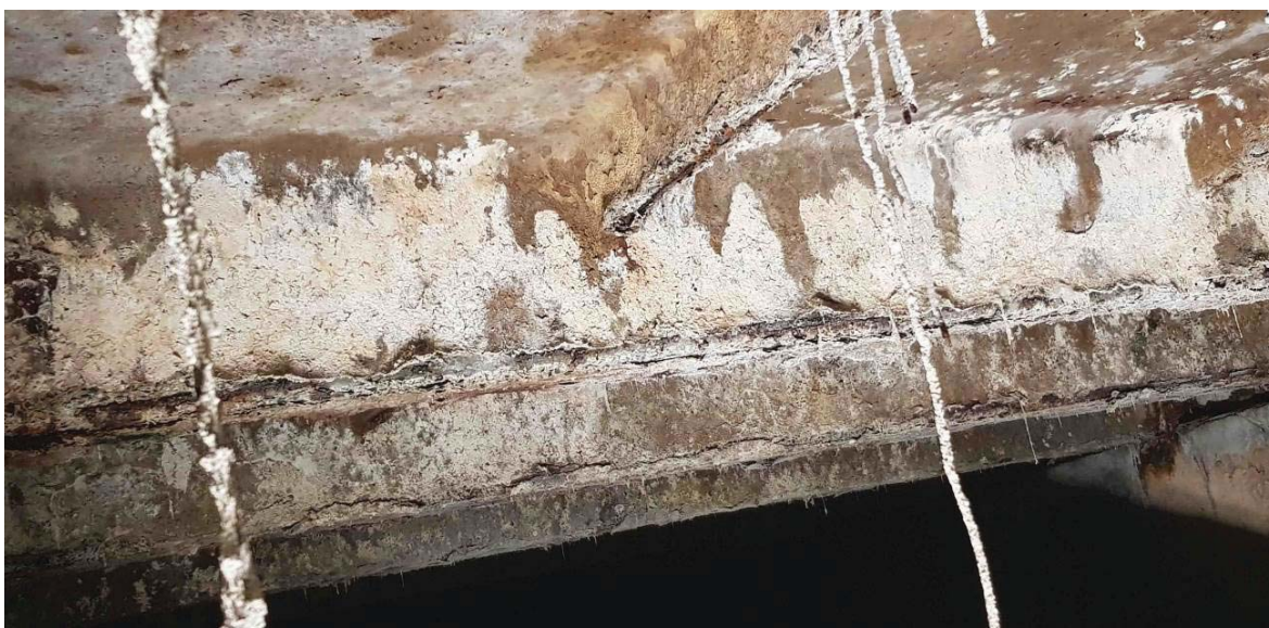
18 pav. Korozijos pažeista G/B perdanga
