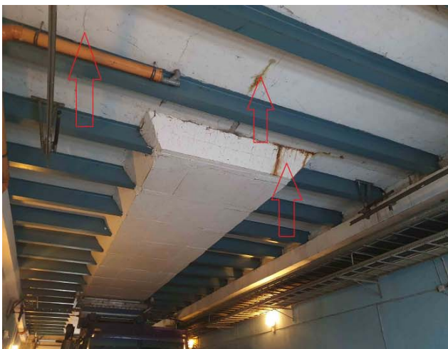
8,9 pav. bunkerio dugno plokštės pažaidos
