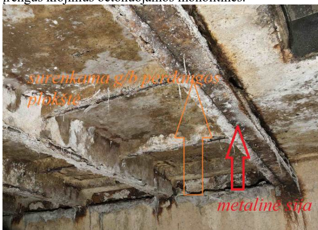
19,20 pav. Dvitėjinės metalinės sijos ir perdangos detalė
