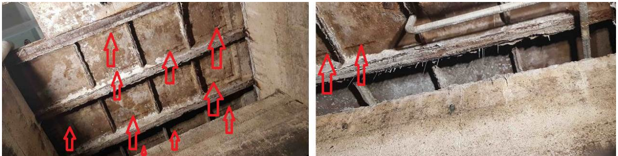
22,23 pav. Korozijos pažeista G/B perdanga
