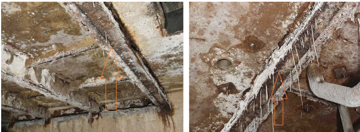
16,17 pav. Dvitėjinės metalinės sijos ir perdangos detalė
