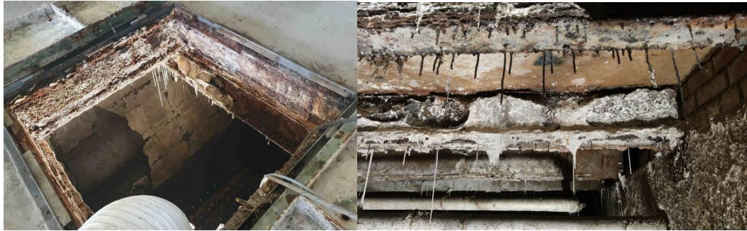
24,25 pav. bunkerio šoninių sienos ir dugnas, lubos,- monolitinio intarpo fragmentas
